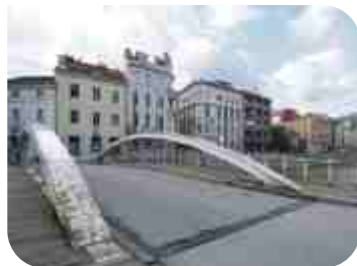
Sarajevo Čumurija Bridge
